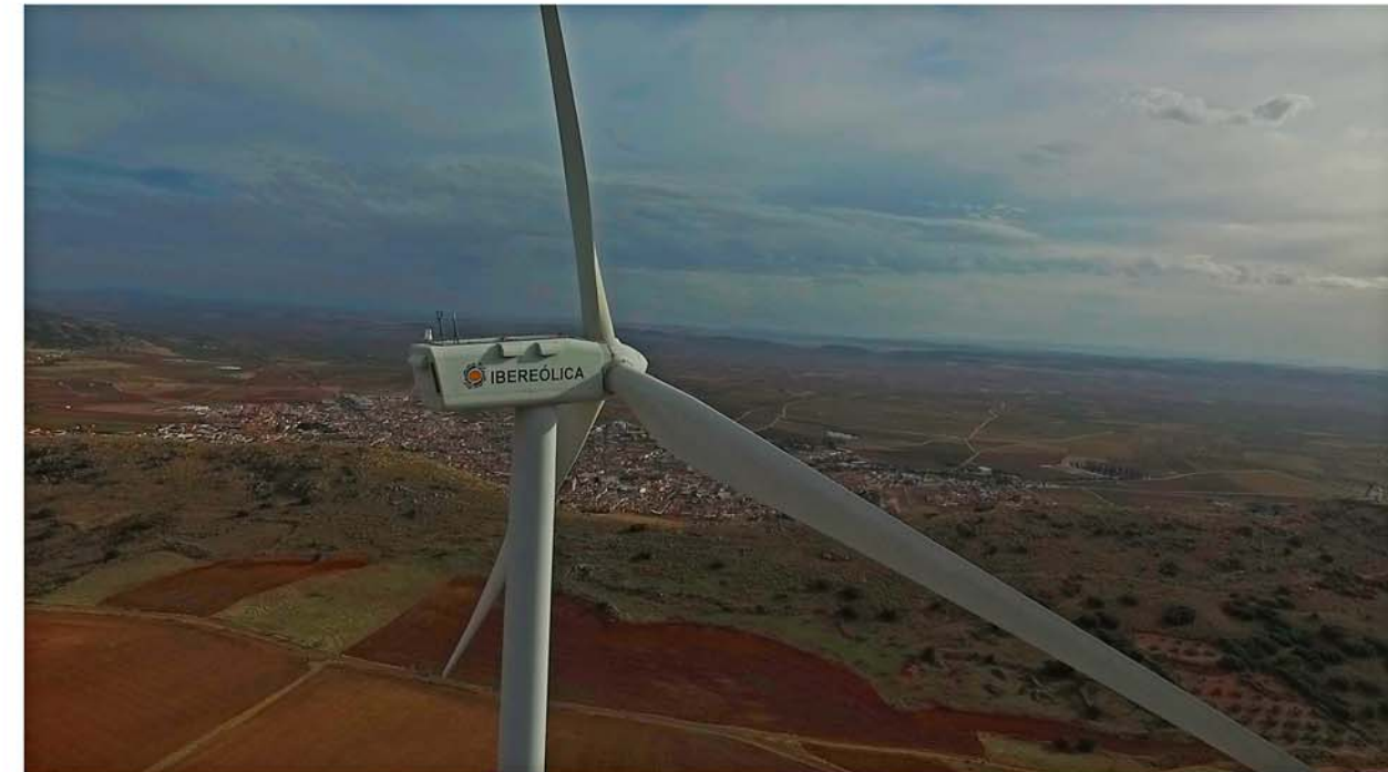
2.- Inspección de parques eólicos.
